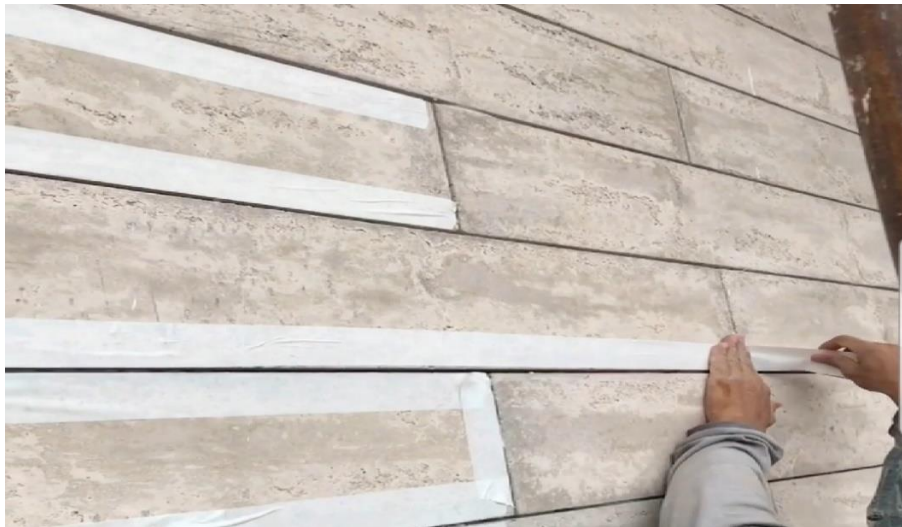
FIGURA 23. APLICAÇÃO DA FITA CREPE PARA REJUNTE INTERNO
