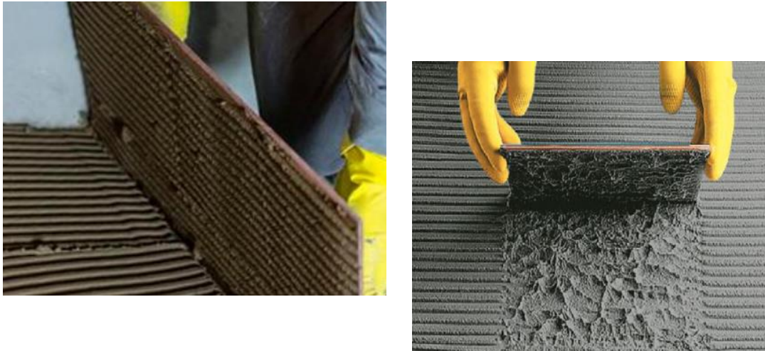
FIGURA 4. APLICAÇÃO DA ARGAMASSA EM COLAGEM DUPLA
