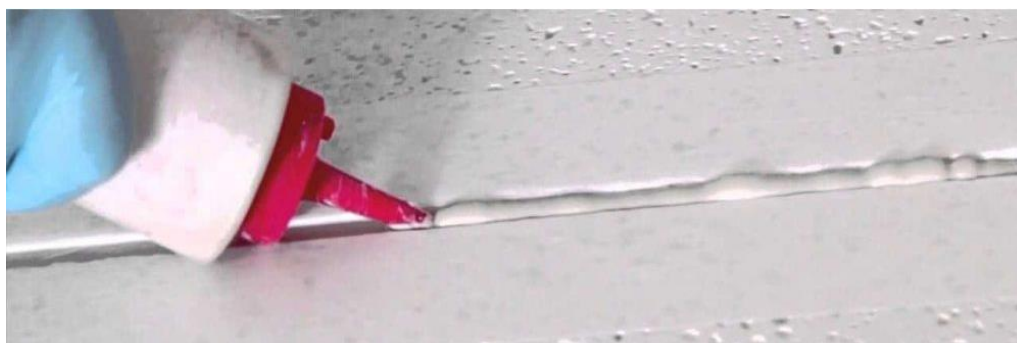
FIGURA 30. APLICAÇÃO DO REJUNTE COM A BSNAGA
