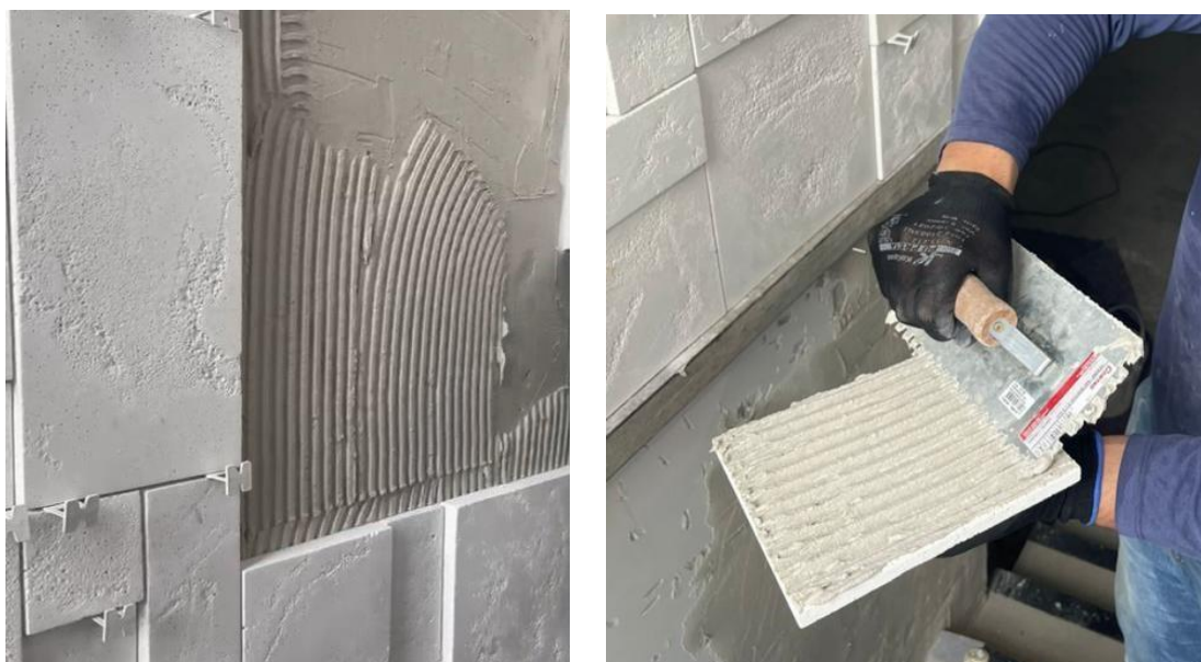
FIGURA 29. MODO DE APLICAÇÃO DA ARGAMASSA
